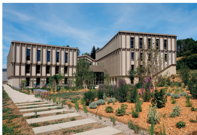
Doc. Malerba / © AIA Life Designers, architectes - adagp 2026 / Photo : Johan Méallier Photographie
