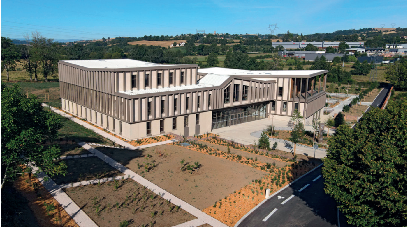
Doc. Malerba / © AIA Life Designers, architectes - adapt 2026 / Photo : Johan Méallier Photographie
