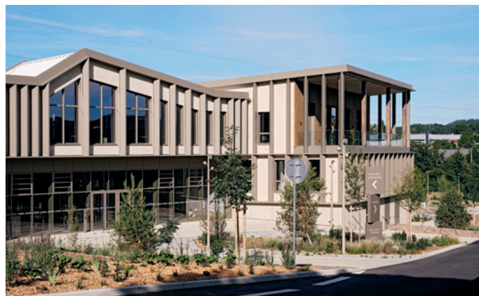
Doc. Malerba / © AIA Life Designers, architectes - adapt 2026 / Photo : Johan Méallier Photographie
