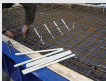
Les différentes étapes de mise en œuvre de Schöck Isolink®, depuis la préfabrication en usine jusqu'à la pose des panneaux sandwich sur chantier.
